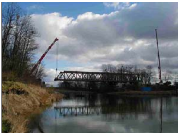
Montage des neuen Brückengerätes SS80 am 13.02.02
