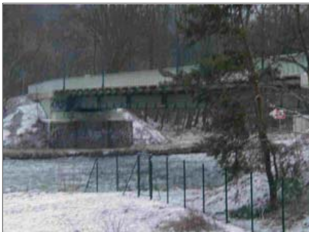
altes Brückengerät SB 30 am 22.01.02
