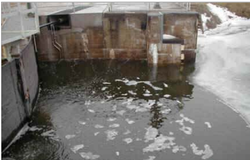
Eisfreihaltung durch eine Luftsprudelanlage am Binnenhaupt
