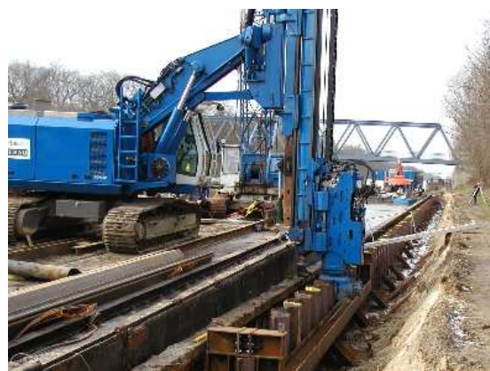
Rammarbeiten am MLK im Bereich Bramsche
