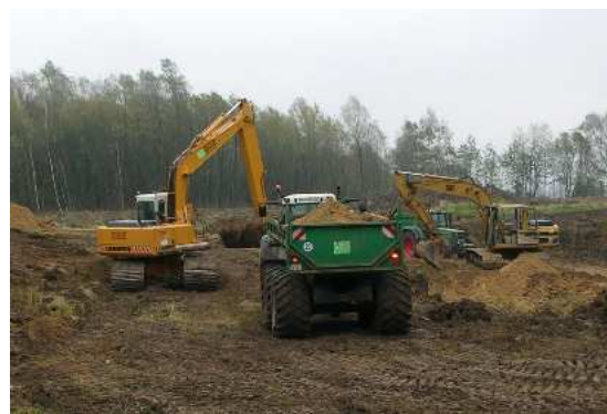
Vorbereitung der Ablagerungsfläche für ca. 76.000 Kubikmeter Baggergut in Herringhausen
