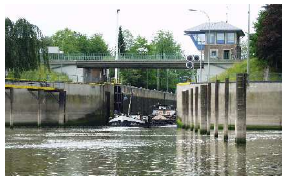
Die Schleuse Landesbergen wird jetzt auch fernbedient.
