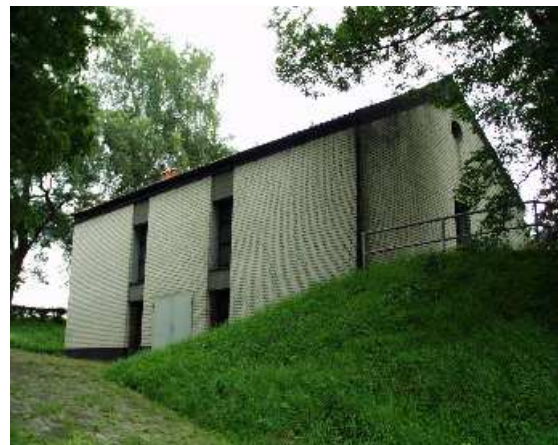
Das Gebäude des alten Pumpwerks
