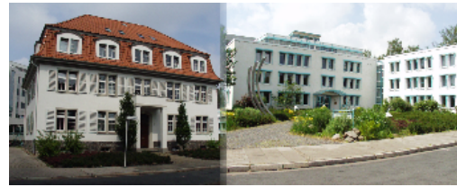
Wasser- und Schifffahrtsamt Minden mit Fernbedienzentrale Schleusen und Betriebszentrale Wasserbewirtschaftung
