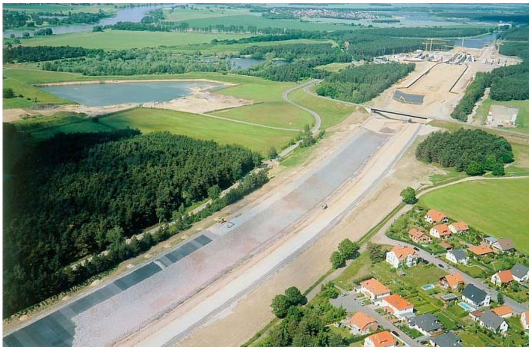
Abb. 3 Stand der Bauarbeiten im Sommer 2002
