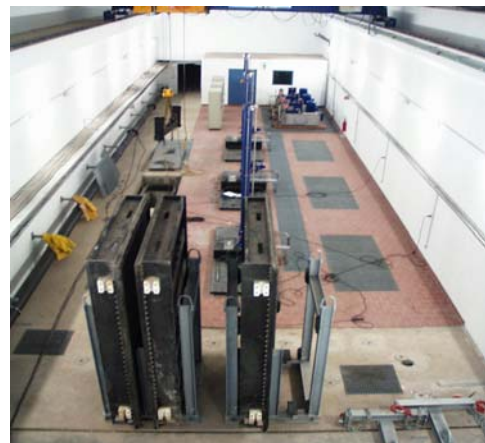
Abb. 5 Maschinenhalle innen mit Schützen druckwasserdichten Deckeln
