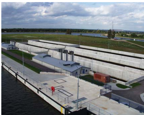
Abb. 4 Maschinenhalle mit Be- und Entlüftungstürmen
