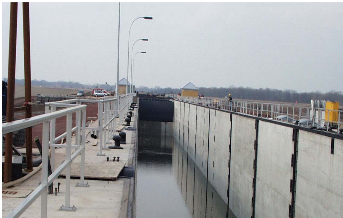
Abb. 2 Schleusenobertor und Schleusenausrüstung
