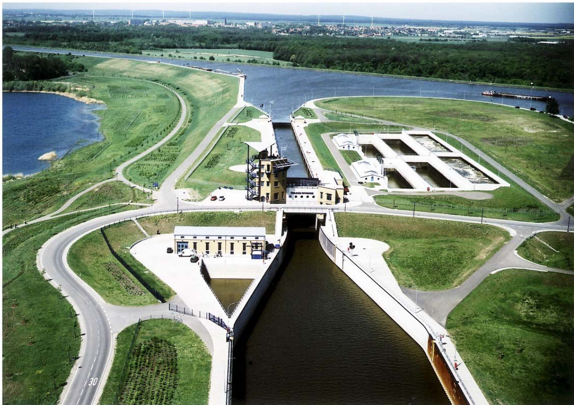
Abb. 1 Übersicht der Schleusenanlage Rothen
