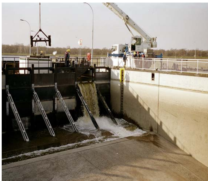
Abb.6 Schleusenrevisionsverschluss im Oberwasser
