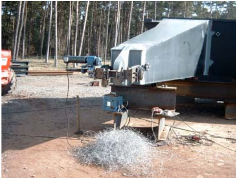
Abb. 15 Mechanische Bearbeitung Stoßschutz
