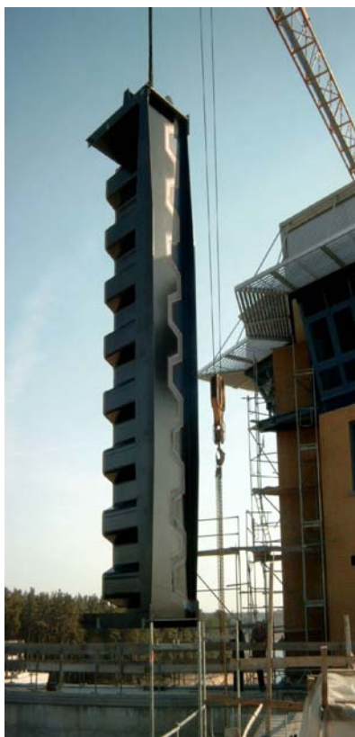
Abb. 13 Einheben Untertor
