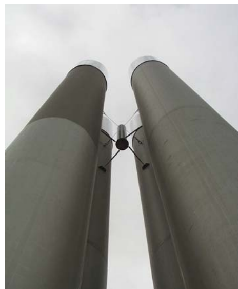
Abb. 4 Schwingungsdämpfer
