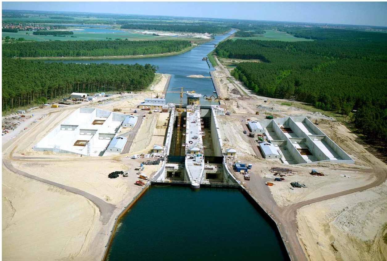
Abb. 1 Übersicht der Schleusenanlage Hohenwarthe
