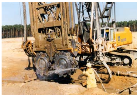
Abb. 4 Dichtwandfräse
