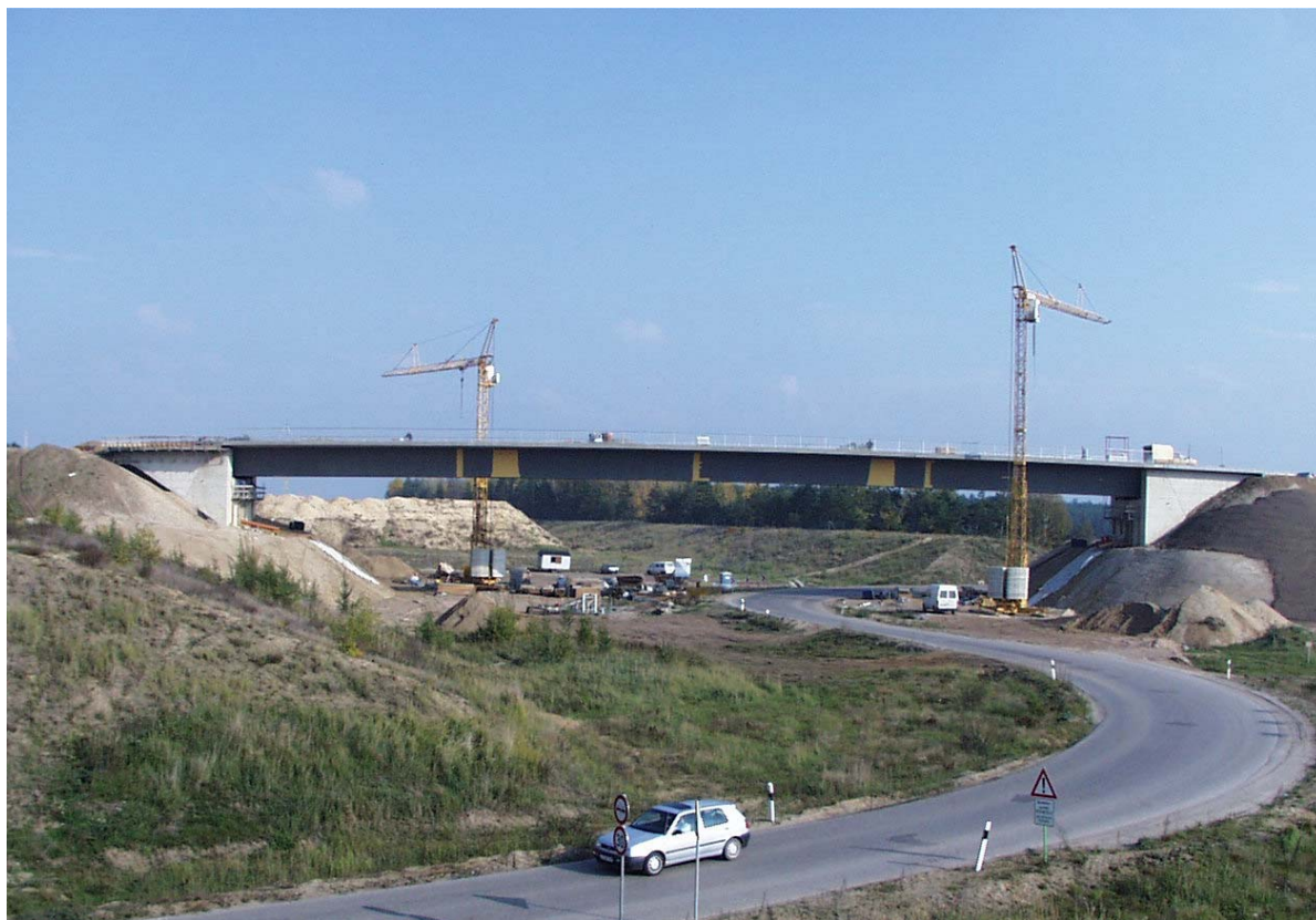
Abb. 1 Bauzustand im Oktober 2000
