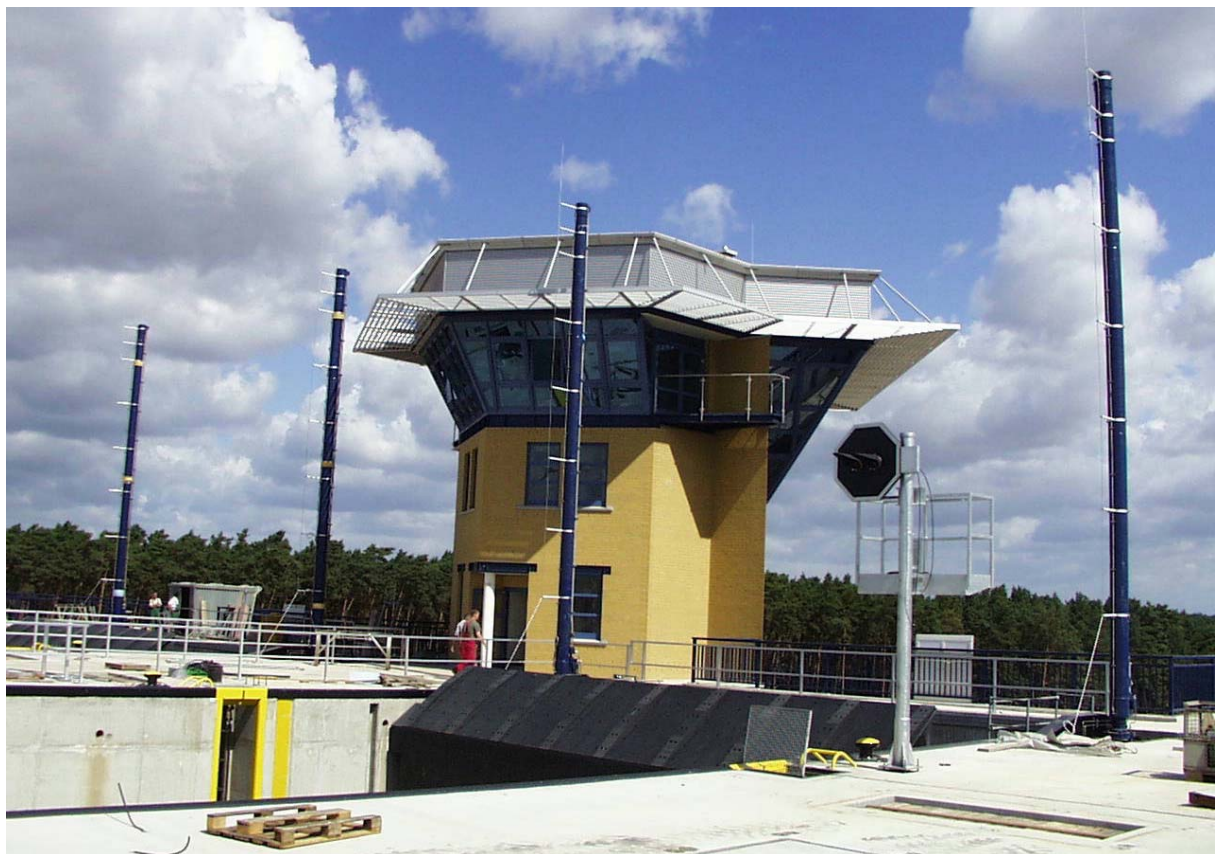
Abb. 10 Hydraulikzylinder der Hubtorantriebe
