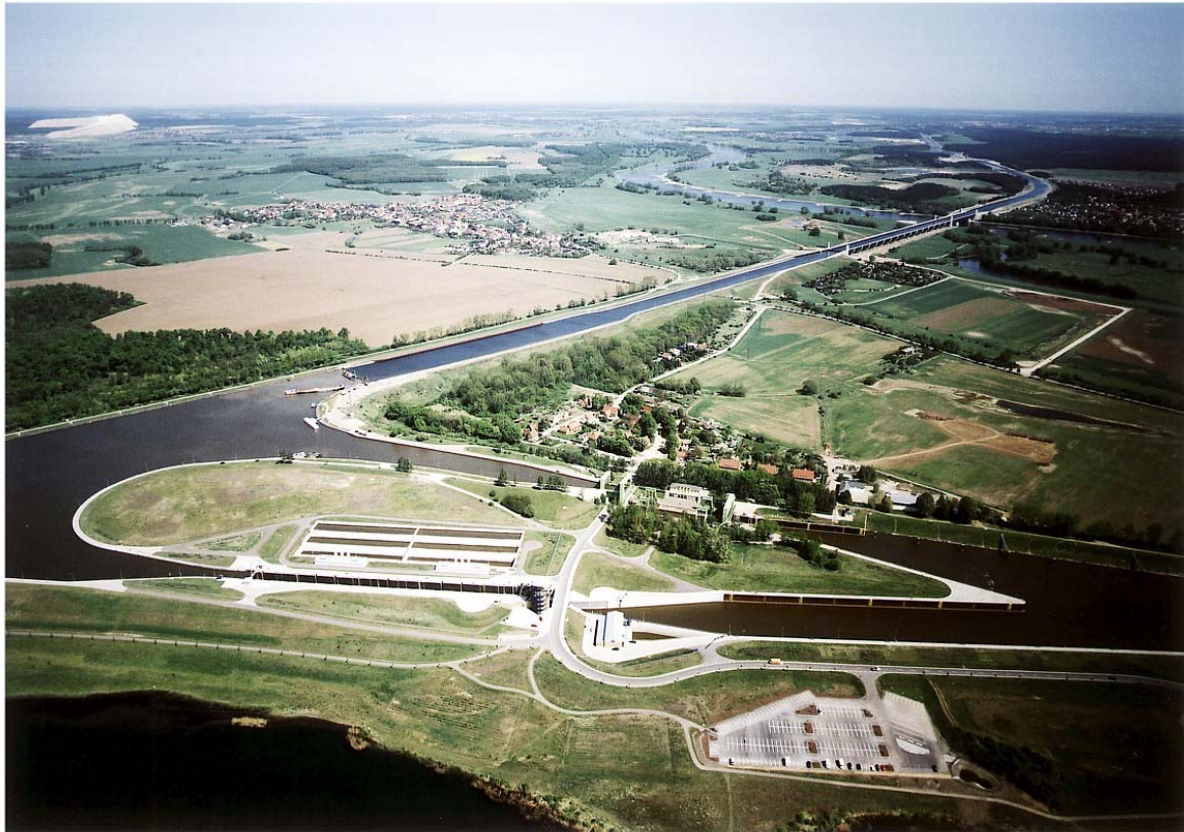
Abb. 1 Luftbild des Wasserstraßenkreuzes Magdeburg
