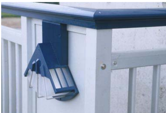
Abb. 8 Die Fuß- und Radwegleuchte ist integraler Bestandteil des Brückengeländers
