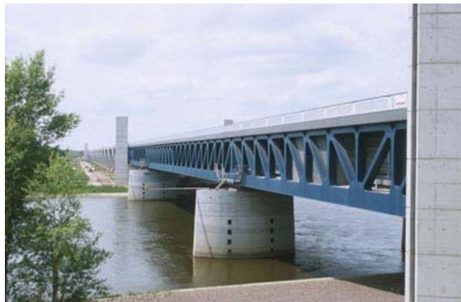
Abb. 7 Die Strombrücke der Elbeüberquerung mit ihren seitlichen Fachwerkträgern
