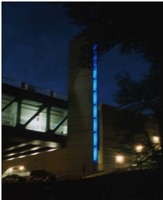
Abb. 11 Auch bei Nacht ist die Kanalbrücke ein schönes Bauwerk
