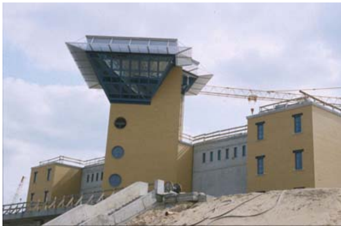
Abb.3 Ansicht des Schleusenbetriebsgebäudes der Doppelkammerschleuse Hohenwarthe vom Unterwasser des Elbe-Havel-Kanals
