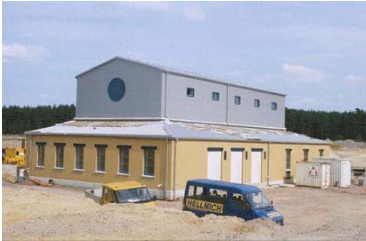
Abb. 4 Ansicht des Pumpenhauses der Doppelkammerschleuse Hohenwarthe
