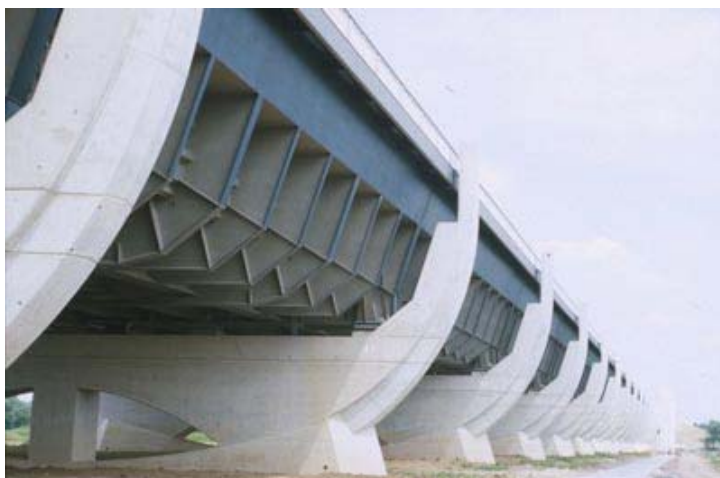
Abb. 5 Die Vorlandbrücke - Der Tausendfüßler der Ingenieurbaukunst
