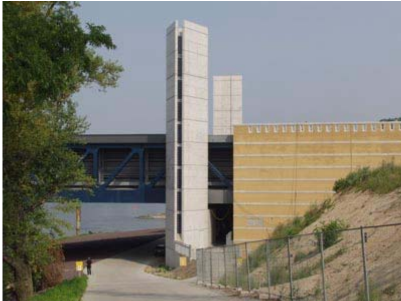
Abb. 9 Der südöstliche Pylon der Kanalbrücke mit der Aussichtsplattform
